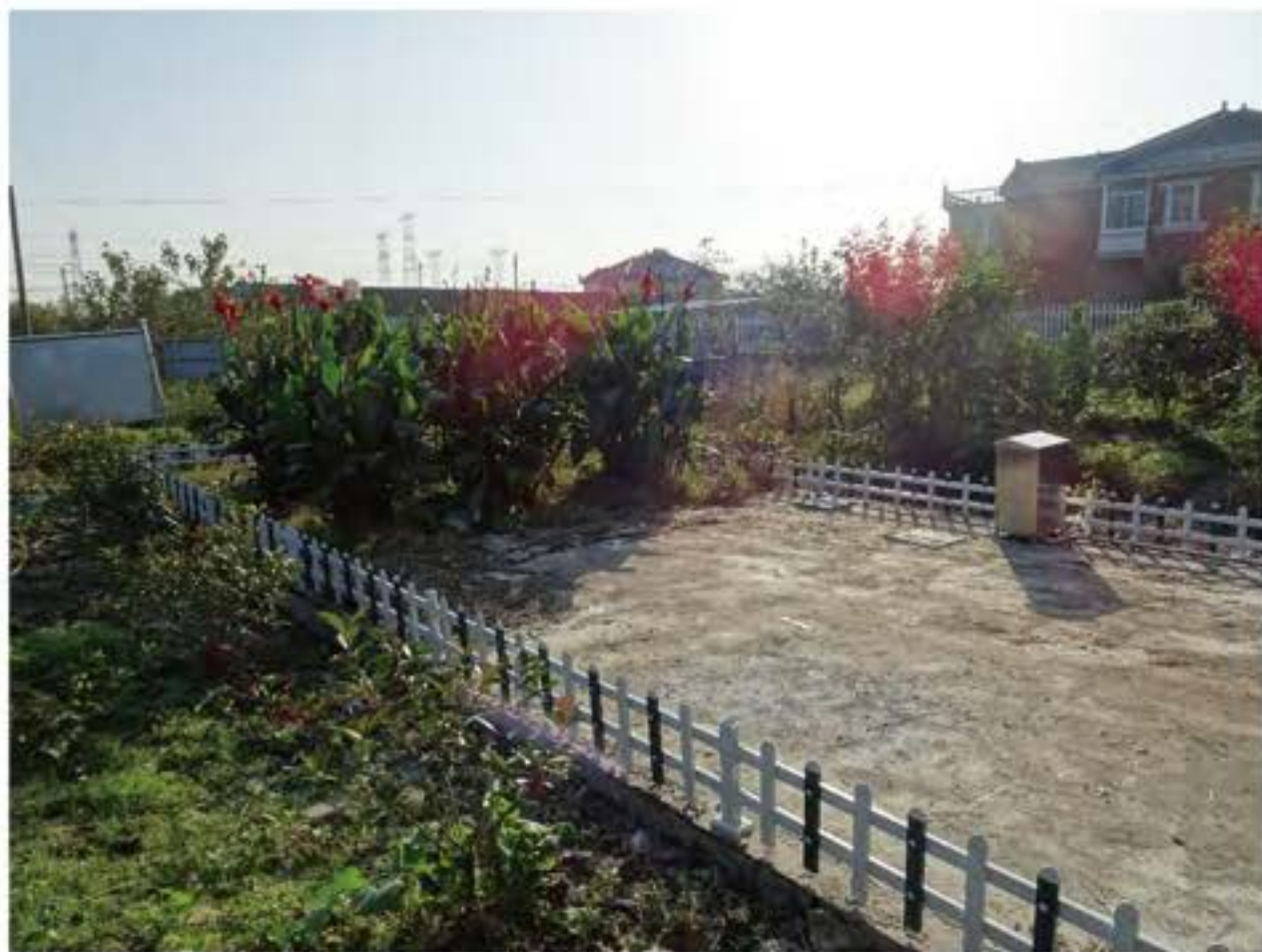
湖州市南得区双林镇某污水处理站
