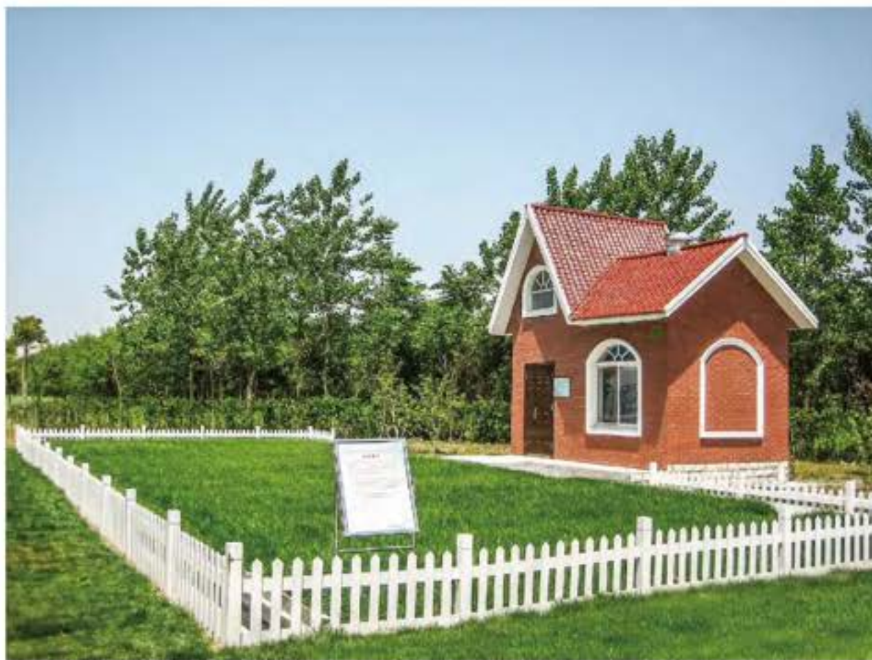
上海市松江区泖港镇某处理站
