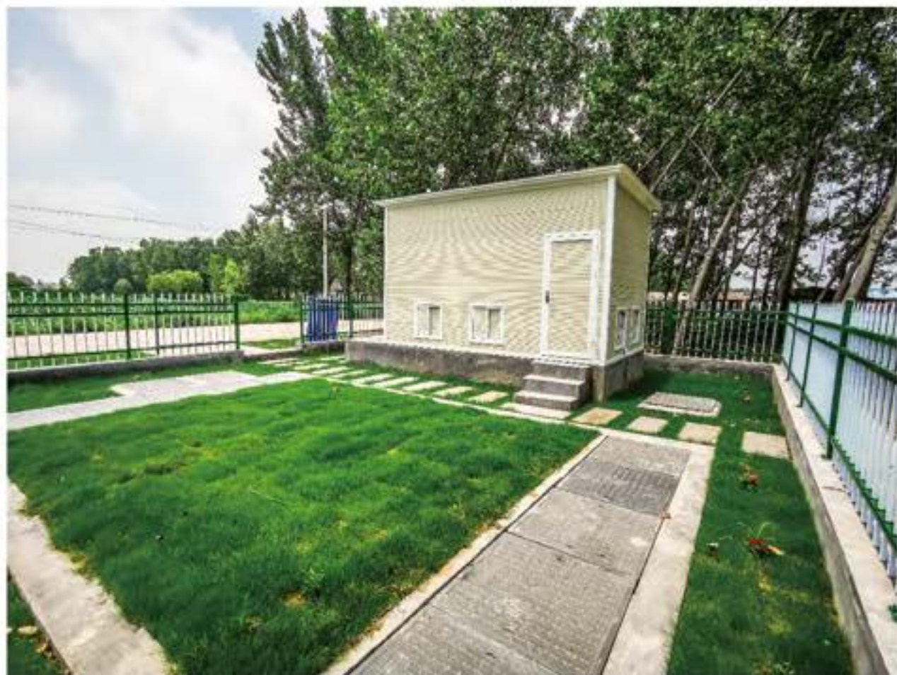
徐州市沛县魏庙镇某污水处理站
