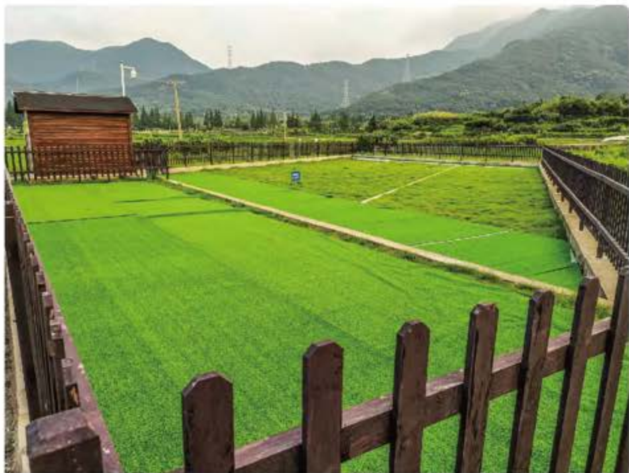
宁波市象山县东陈乡某污水处理站
