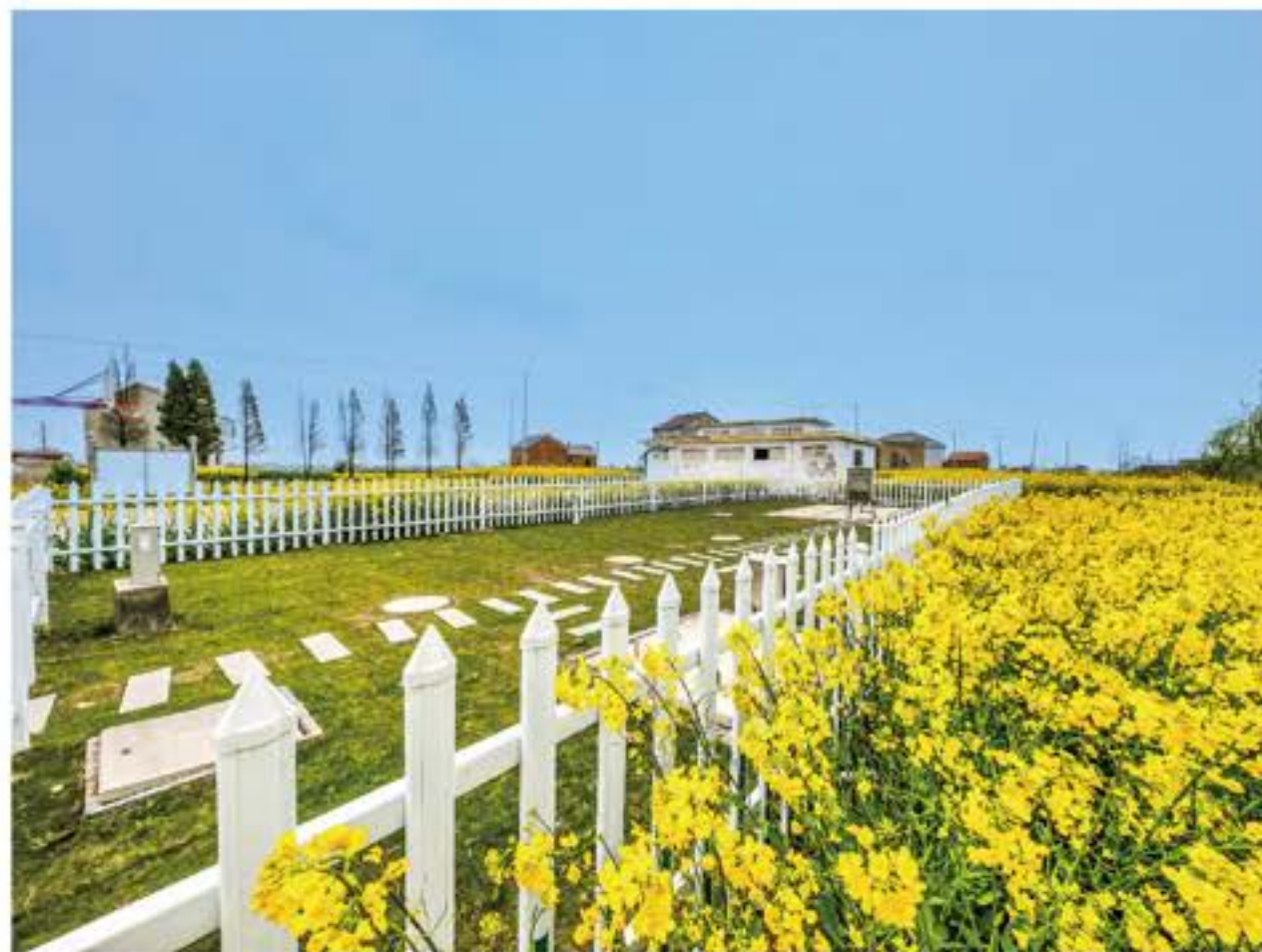
盐城市滨海县八滩镇某处理站
