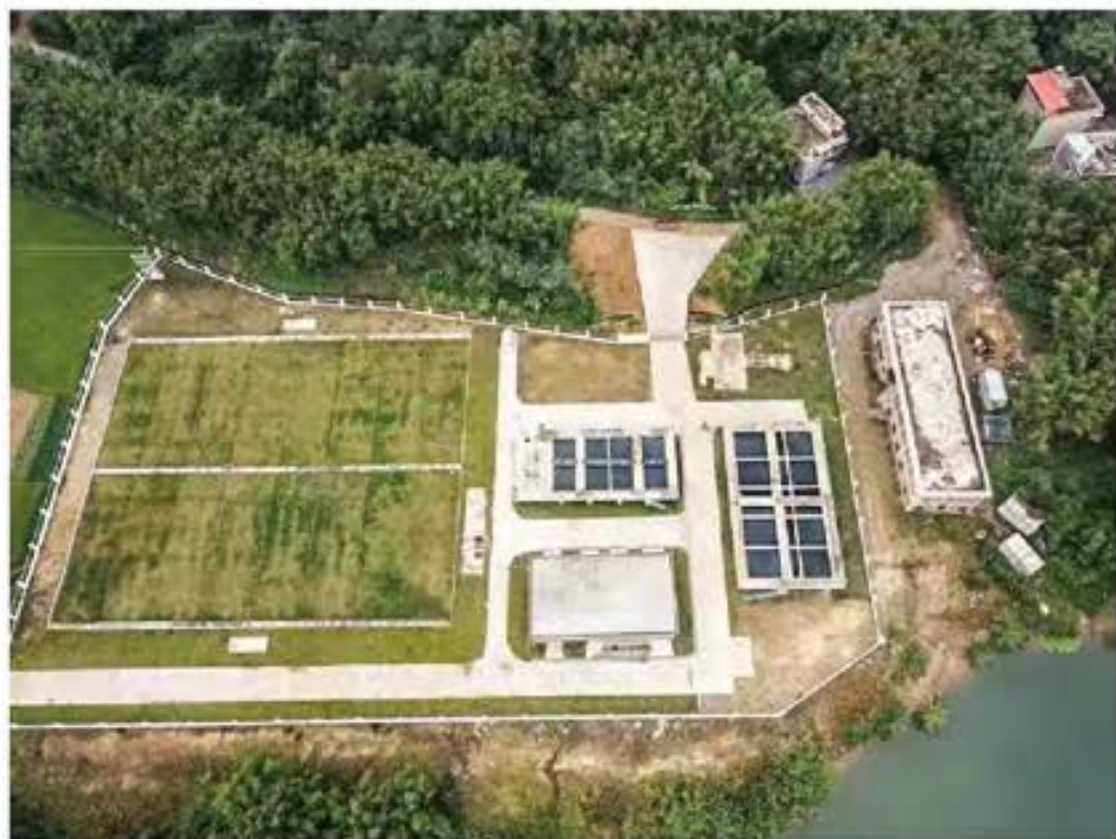
韶关市武江区龙归镇污水处理厂,处理量3000m 3 /d
